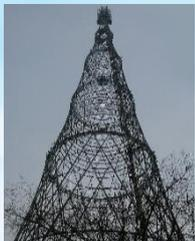
В. Г. Шуховым телевизионная башня представляет собой телескопическую конструкцию высотой около 160 м и включает шесть сетчатых гиперболоидных секций. Каждая секция имеет необычайную прочность
